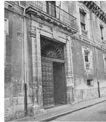
Fig. 109. Casa número 12 de la calle Ruiz Hernández. La portada está montada en el interior del nuevo inmueble.
