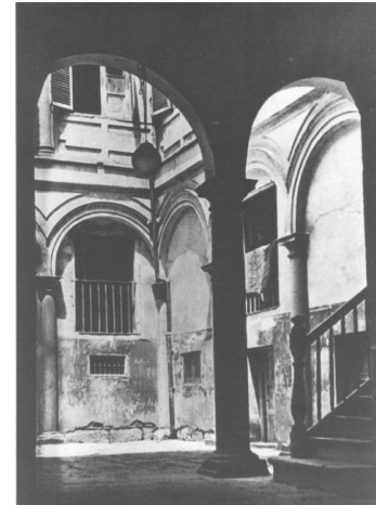
Fig. 59. Patio de la casa número 9 de la calle del Prado. [Fuente: Urrea].
