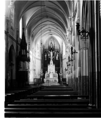
Fig. 114. Vista interior de la Iglesia jesuítica, antes de ser derribada. Años 40-50.
