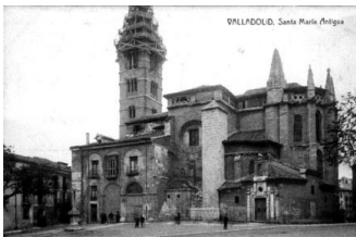
Fig. 32. Iglesia de Santa María la Antigua antes de su derribo y reconstrucción. [Fuente: AMVA Archivo fotográfico].
