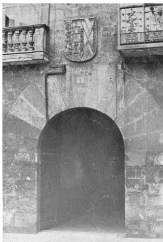
Fig. 107. Portada de la Casa de los Alarcón. [Fuente: MARTÍN GONZÁLEZ, J.J.1948. La arquitectura doméstica del renacimiento en Valladolid .
