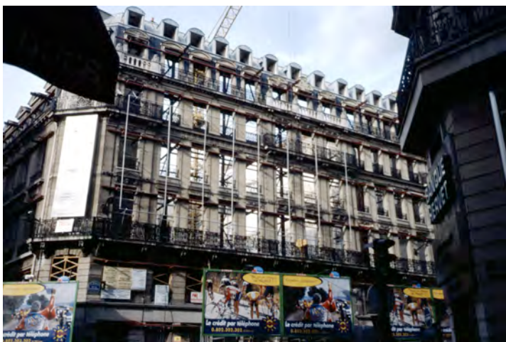
Figura 96: París, Rue du Quatre de septembre. Un edificio de viviendas se prepara para convertirse en oficinas. (Fuente: la autora)
