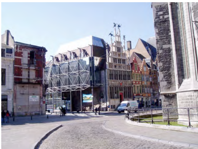
Figura 100: Gante. La fachada de un antiguo inmueble presta la cara a una nueva edificación. (Fuente: la autora)
