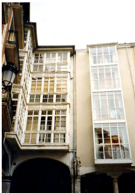
Figura 185: Miradores de la calle de Sombrerería: de madera a PVC. (Fuente: la autora)
