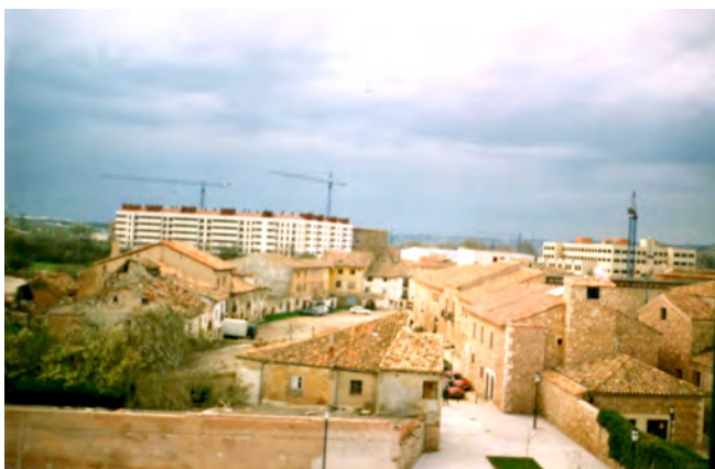
Figura 61: Plaza del Sobrado, ya “calle”, después del derribo de la casa propiedad de la Universidad de Burgos. (Fuente: la autora)
