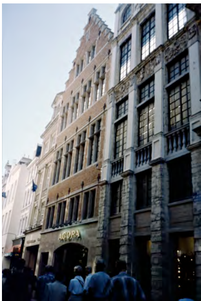
Figura 110: Bruselas. Dos edificios de viviendas unidos, convertidos en un solo comercio. (Fuente: la autora)
