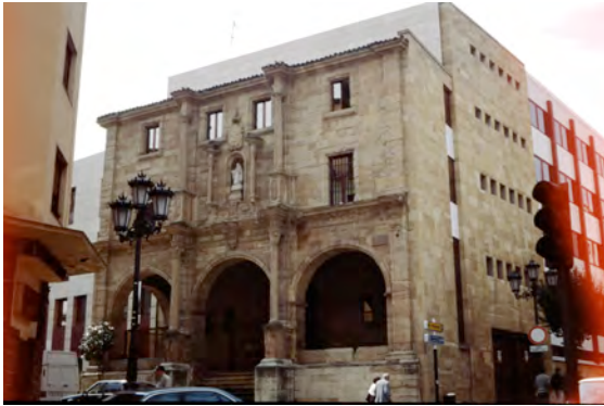
Figura 114: Oviedo. La fachada actúa como una escultura antepuesta a este edificio institucional. (Fuente: la autora)
