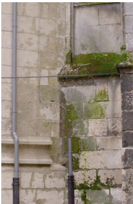
Figura 210: Catedral de Burgos. Humedad y musgo en el paramento de la girola. (Fuente: la autora)
