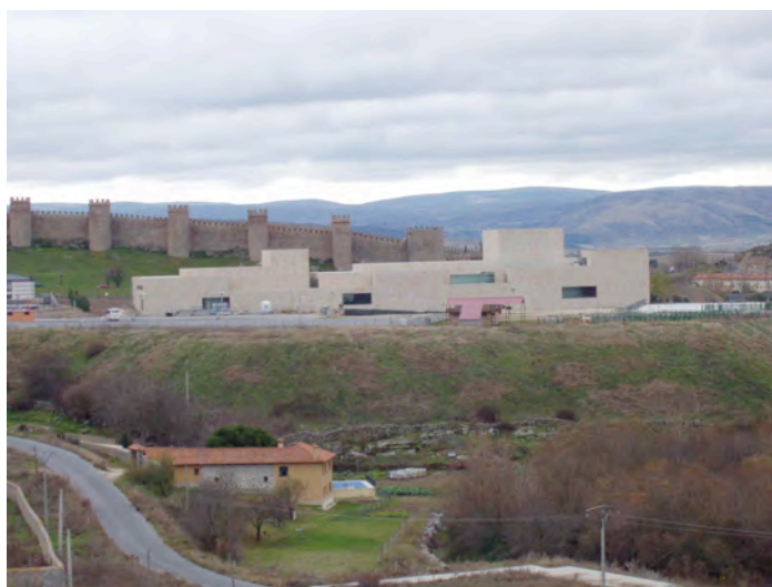
Figura 239: Desde la Universidad Católica de Ávila. El edificio de Fco. Mangado "integrado" en el lienzo norte de la muralla. (Fuente: la autora)
