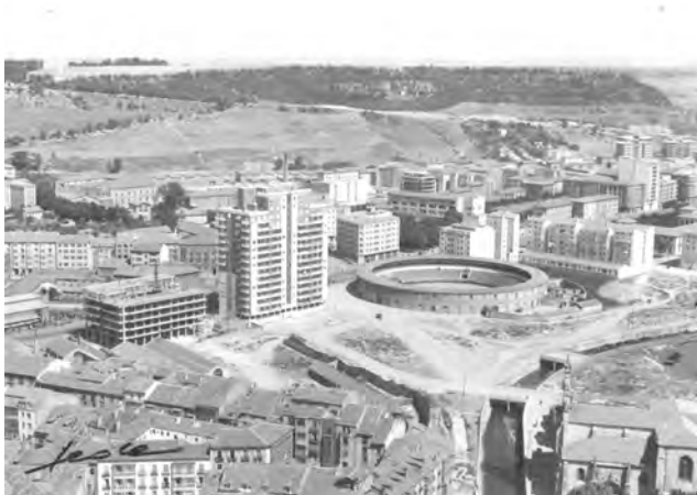
Figura 43: Plaza de toros y edificio Feygon en la zona de los Vadillos. (Fuente: Foto Fede)
