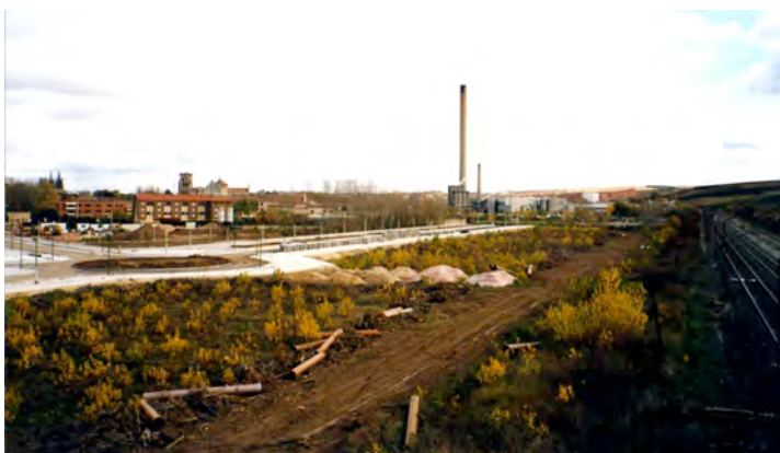
Figura 78: El Monasterio de Las Huelgas será rodeado por las edificaciones previstas por el planeamiento una vez demolida la Cellophane y eliminadas las antiguas vías del ferrocarril. (Fuente: la autora)
