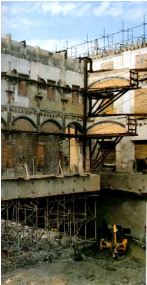
Figura 116: Burgos. Casa del Cordón. De palacio a sede de la Caja de Burgos. (Fuente: Caja de Burgos)
