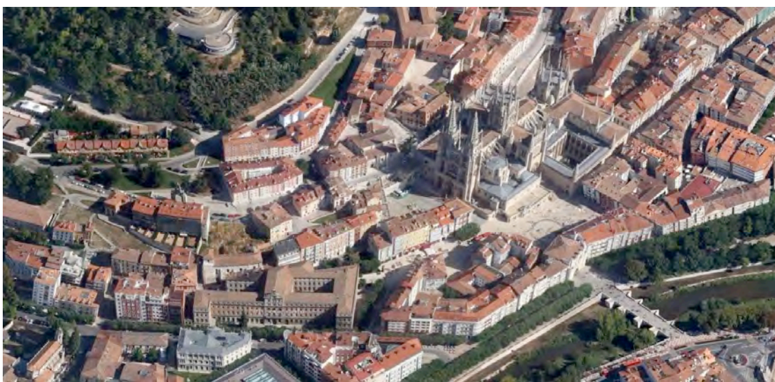
Figura 207: Burgos. Panorámica cenital de la Catedral y su entorno. (Fuente: Ayuntamiento de Burgos)
