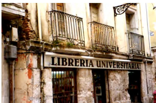
Figura 138: Burgos. Edificio vacío excepto el bajo comercial. (Fuente: la autora)
