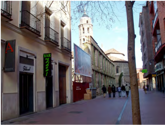
Figura 112: Valladolid. Fachadismo junto a la iglesia del Salvador. En la actualidad ya está reconstruida. (Fuente: la autora)
