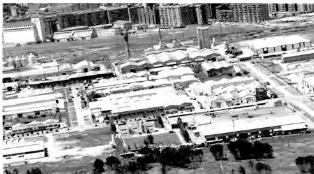
Figura 37: Las naves de PENTASA, en contacto con las viviendas de los años ochenta. (Fuente: Lorenzo Matías)
