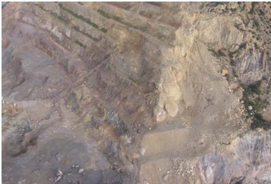
Figura 1. Talud con deslizamiento por una rotura circular
