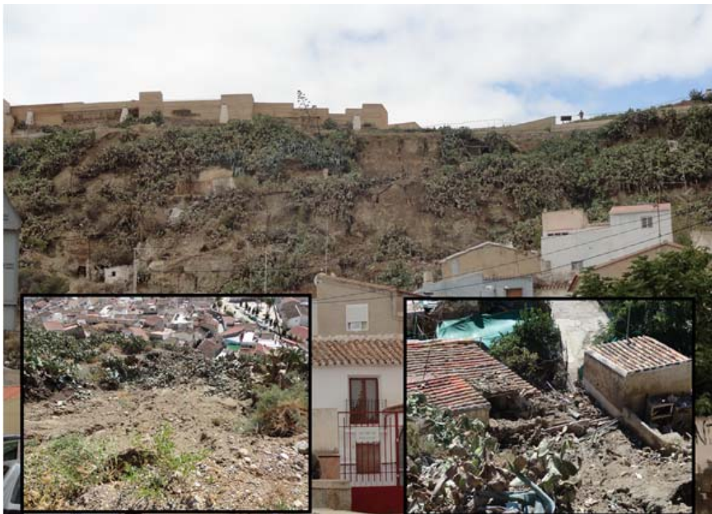
Figura 7. Talud de Puerto Lumbreras con deslizamientos sobre viviendas.
