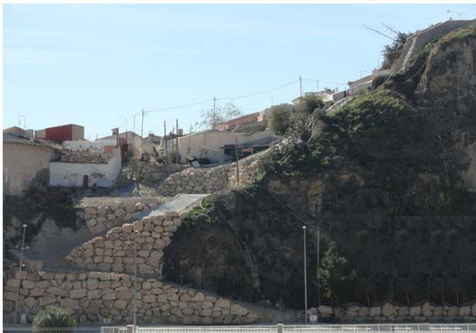
Figura 9. Consolidación y estabilización mediante muros de escollera
