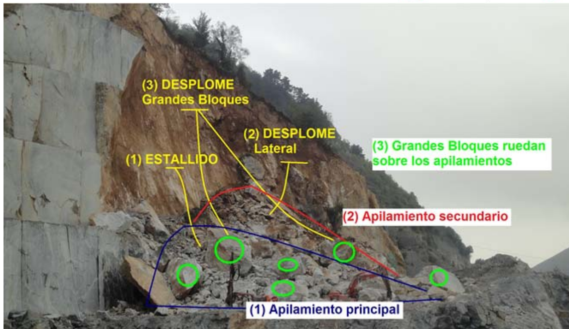
Figura 12. Secuencia de movimientos del desprendimiento.
