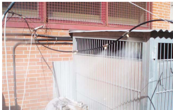
Figura VI.15.- Vista de la instalación para ensayo del refrescamiento de espacios exteriores.
