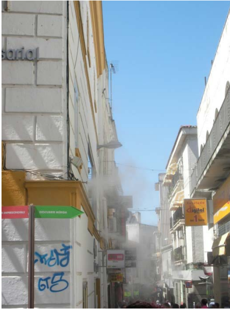
Figura VI.1.- Sistemas de pulverización de agua operando para refrescamiento de una calle en Mérida.
