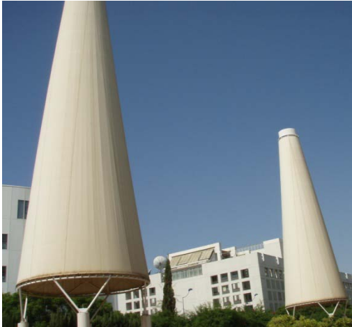
Figura VI.6.- Torres de tiro invertido con pulverizadores interiores para acondicionamiento del aire exterior en la Expo Sevilla 92.
