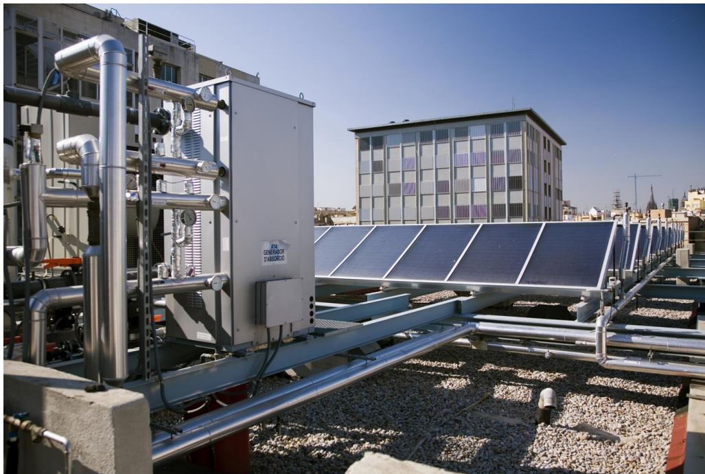
Figura 10. Instalación externa de sistema de aire acondicionado por absorción utilizando colectores solares planos. [5]
