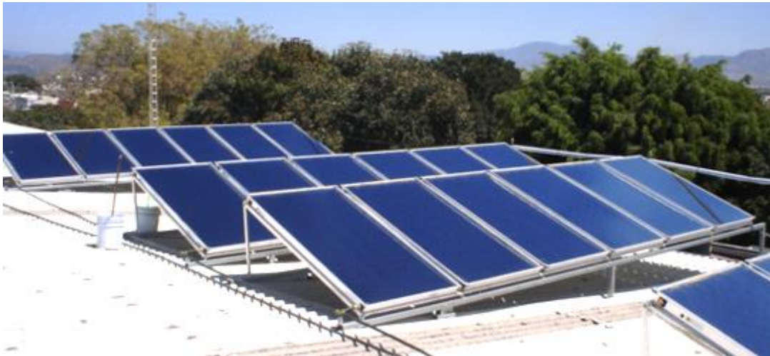
Figura 11. Instalación de campo solar en el techo de un local. [5]
