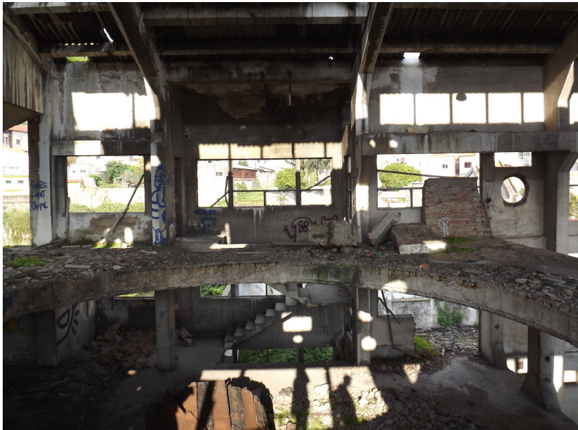
João Alves Central Termoelétrica do Freixo (17 de Novembro de 2016) Fotografia
