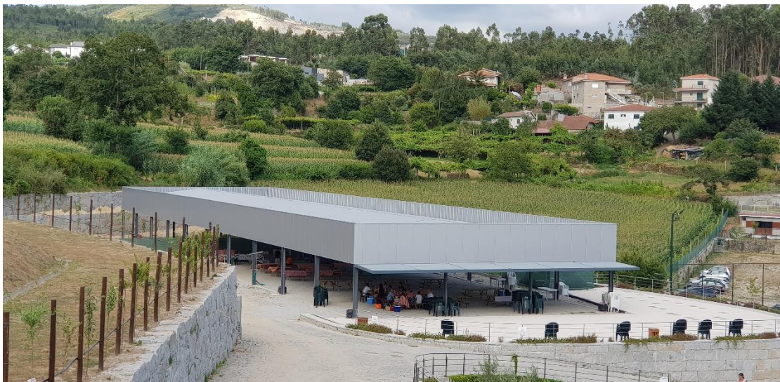
Fotografia 2. Vista do Armazém, onde vão ser colocados os Painéis Solares.
