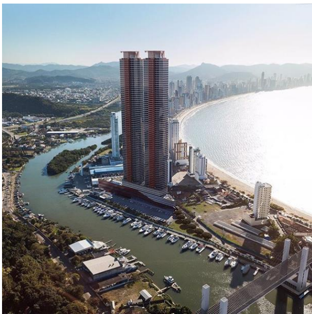
Imagem 07: Construção do YatchHouse Residence Club, com previsão de conclusão em 2019, terá 81 pavimentos e 260 metros de altura.
