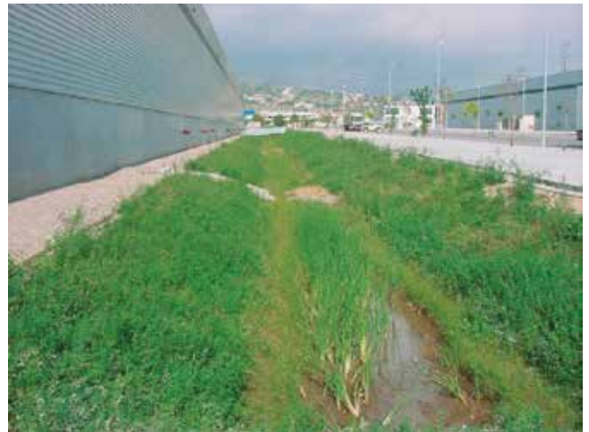
Fig. 2_ Cunetas de laminación paralelas a las naves industriales
