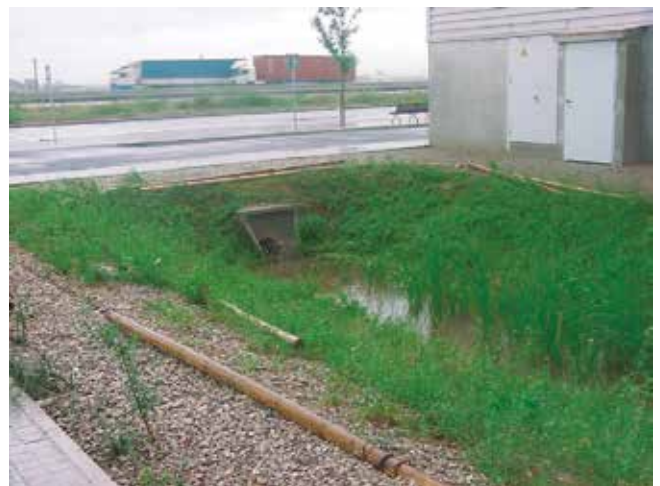
Fig. 3_ Cunetas de laminación: elemento de regulación
