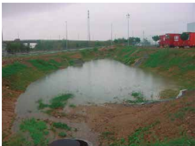
Fig. 4_ Balsas de laminación al final de sistema durante las lluvias de 2002
