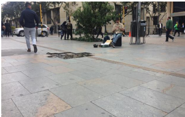
Figura 3. Utilización de roca caliza en el sendero peatonal de la Avenida Jiménez en el centro de Bogotá. Fuente: elaboración propia.
