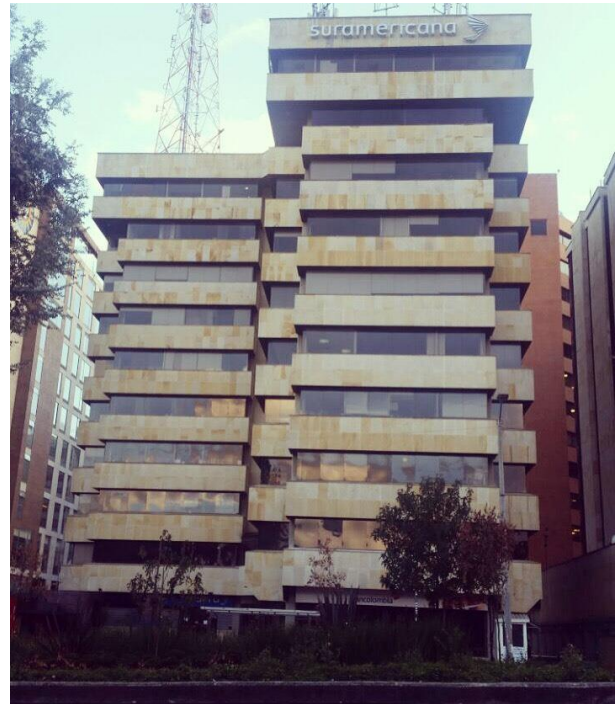
Figura 4. Utilización de Piedra Muñeca en la fachada del edificio de Suramericana ubicado en la calle 72 con carrera 11 en Bogotá. Fuente: elaboración propia.
