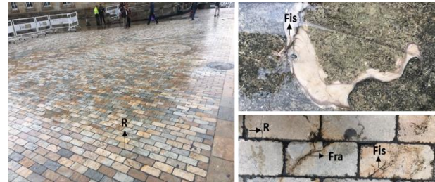
Figura 7: Formas de deterioro en la MRB utilizada en el sendero peatonal de la carrera séptima desde la Plaza de Bolívar hasta Av. Jiménez en Bogotá, Colombia. Fisuras (Fis), Fracturas (Fra) y Redondeamiento (R). Fuente: elaboración propia.
