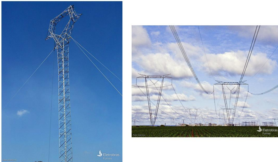
Figura 2.4 – Exemplos de Torres Estaiadas (Fonte: sítio da Eletrobrás)
