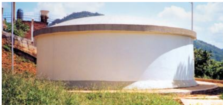
Figura 2.3 – Reservatório apoiado (FUNASA, 2007)
