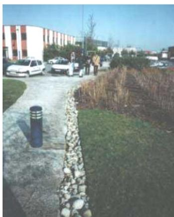
Figura 3.5 - Trincheira de infiltração ao longo de calçada em área comercial em Lyon, França (Souza, 2002).
