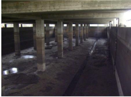
Figura 3.3 - Exemplo de reservatório de detenção coberto.
