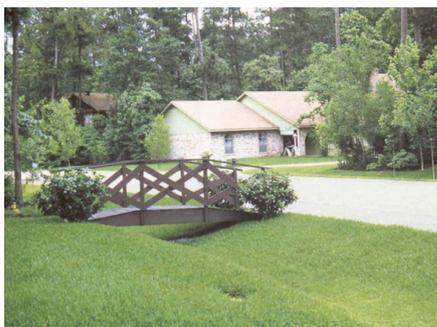
Figura 3.6 - Exemplo de vala de infiltração (Certu, 1998 *apud* Brito, 2006).
