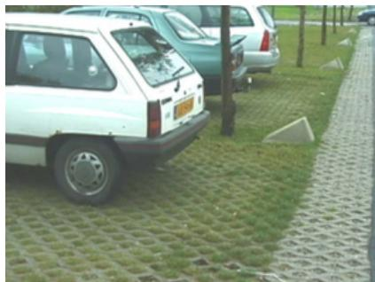
Figura 3.10 – Exemplo de pavimento permeável (CETE DU SUD-OUEST, 2003 *apud* Brito, 2006).
