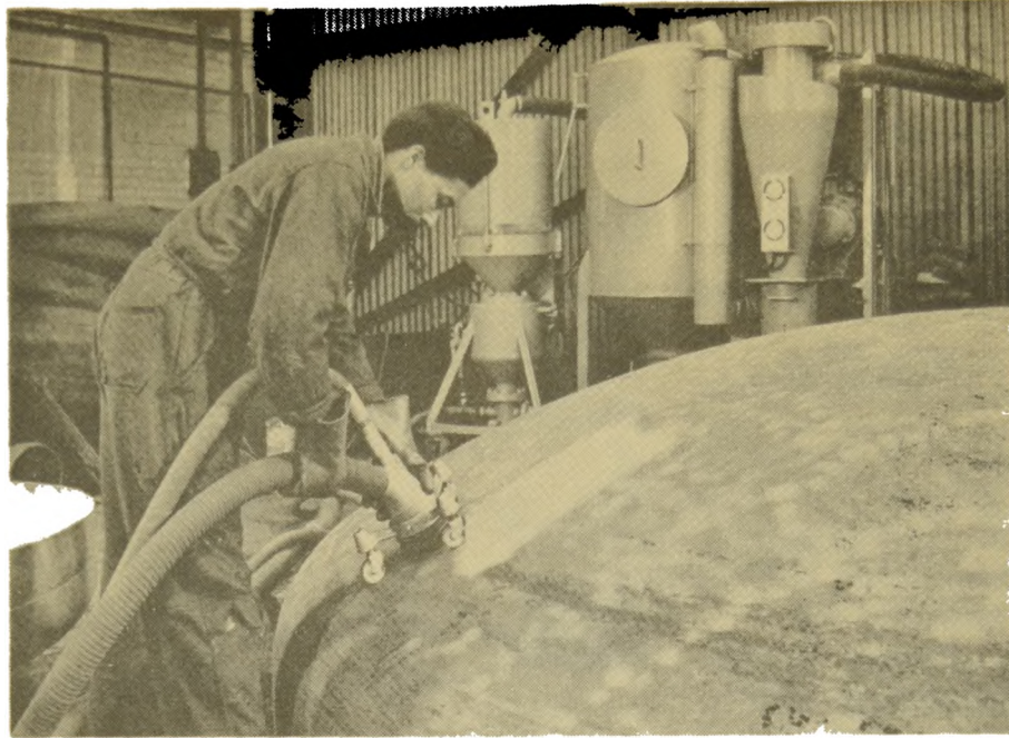
Figura 53.- Limpieza con arena empleando un equipo de circuito cerrado
