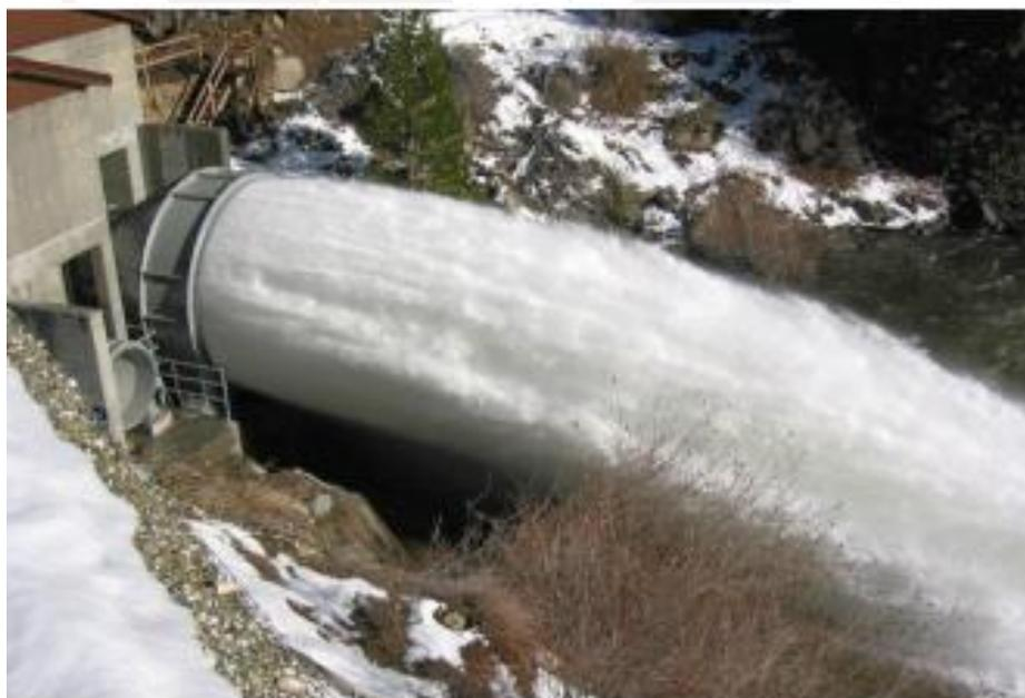
Figura 1.2: Válvula de descarga para caudal ecológico [36]
