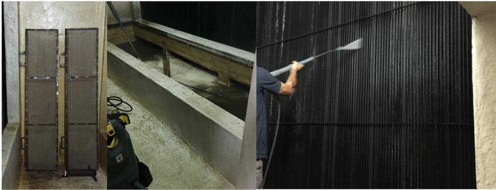
**Figura J.1** – Etapas do processo de limpeza, dos filtros, tanque e separador de gotas, respetivamente
