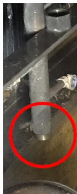
**Figura J.2** – Pormenor da abertura dos tubos conectados aos atomizadores
