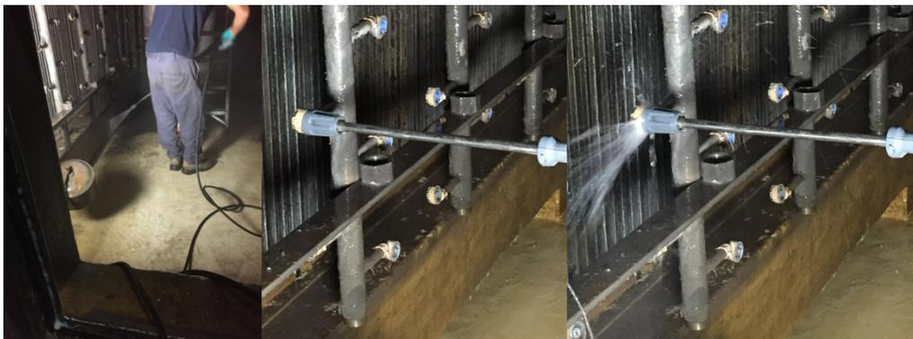
**Figura J.3** – Etapas do processo de limpeza dos atomizadores, por ordem cronológica (esquerda – direita)
