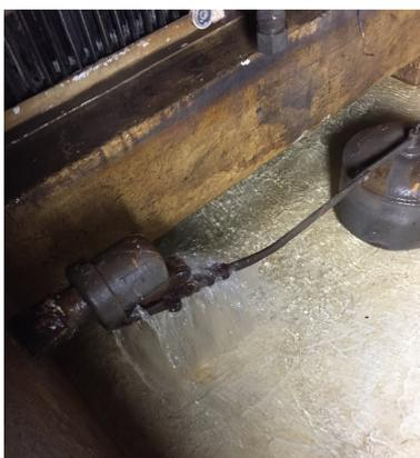
**Figura J.6** – Enchimento do tanque de água – boia de nível
