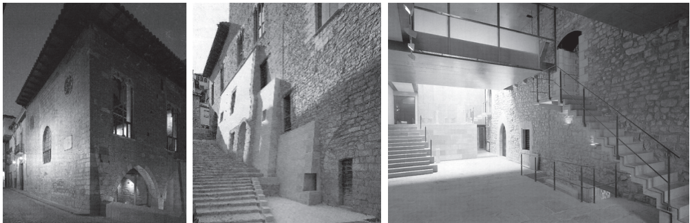
Fig. 2-3-4. Imatgenes del edifici rehabilitado 1997.
