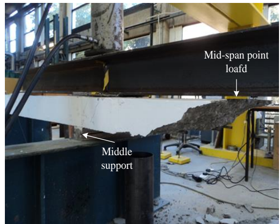
(d) Flexure-shear failure at mid-span of slab C-C-OU
