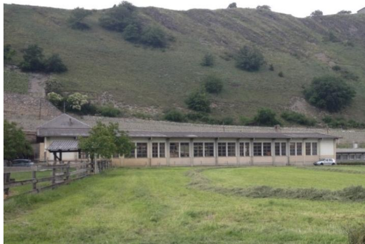
Figure 21 : Toit pour l'installation de PV
