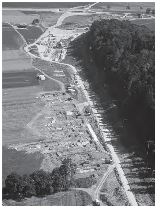
Fig. 7. Vue aérienne du site depuis l'ouest.
