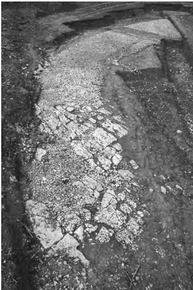
Fig. 3. Vue de la voie de Courtedoux (secteur D). Au premier plan, vers le haut de la pente, les pans de rocher utilisés brut; les interstices ont été comblés par des cailloux.
