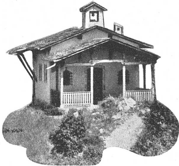
Chapelle dédiée à saint Nicolas de Flüe. Oeuvre de l'architecte Dufour.
