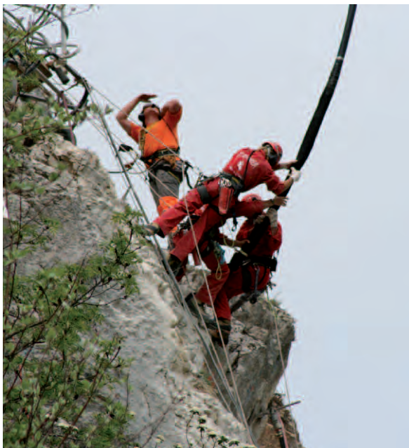
Figure 9: «jumeau», mise en place des tirants d'ancrage en falaise à trente mètres au-dessus de la H18, à l'aide de l'hélicoptère.
