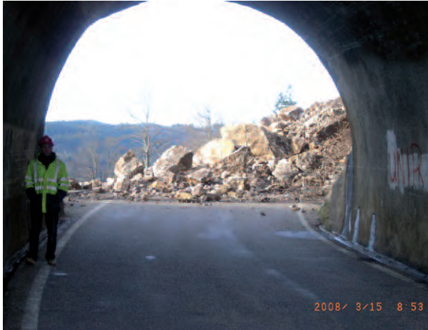
Figure 3: l'accumulation des 200 m 3 de blocs calcaires sur la H18 (vue vers l'ouest depuis l'intérieur du tunnel de la Roche).
