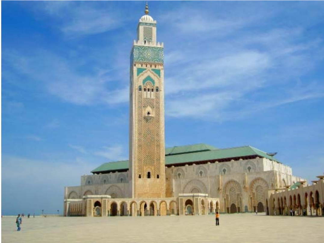
Figure 7 : la Mosquée Hassan II (Source : récupéré le 7 août 2012 de http://www.okvoyage.com/maroc/89-photo-maroc/mosquee-hassan-casablanca.html )
