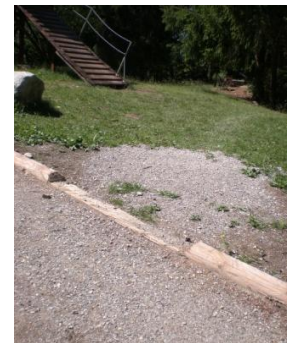
Figure 28: Bois rabaissé pour permettre le passage
