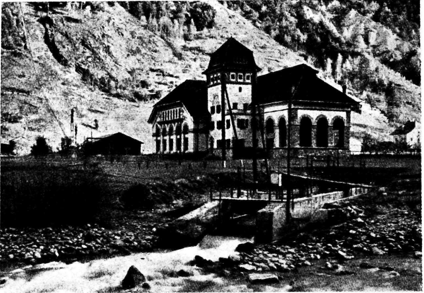
Zentrale mit Unterwasserkanal
