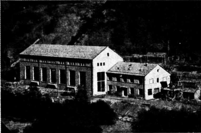
Vue de la Centrale
