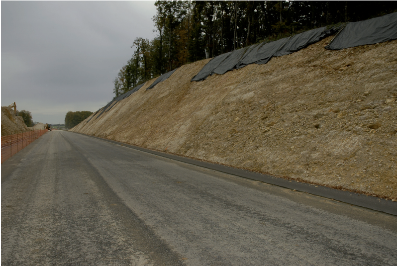
Fig.6 : Vue générale du site de Buix-Tchouattes.
