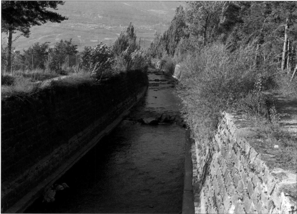
Fig. 23 – La Morge canalisée à l’aval de la ligne de chemin de fer.
