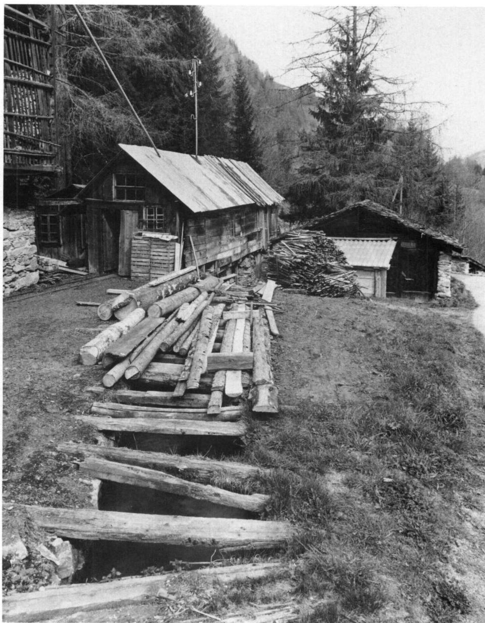
Pl. XXIII. — La scierie et la ribe vues du sud. Au premier plan, l'aménée d'eau, partiellement recouverte, sert d'entrepôt pour les troncs. Photo Fibbi, 1984.
