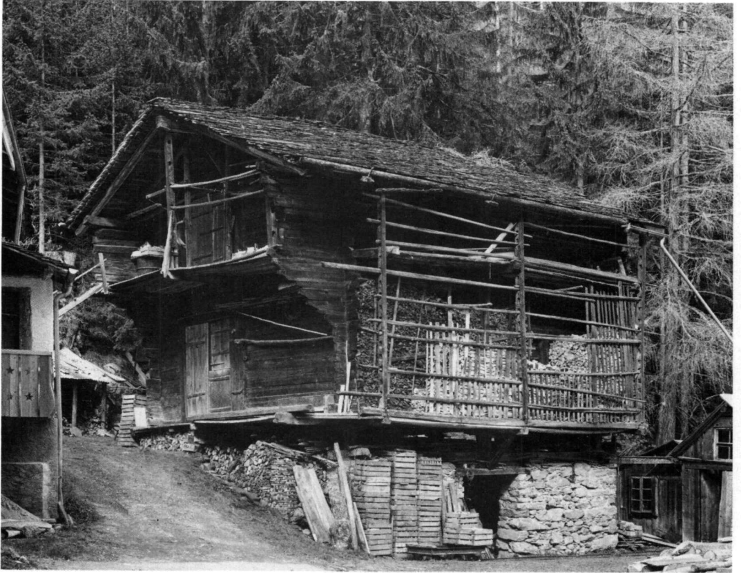
Pl. VI. — Le raccard de 1749, façades sud et est. Photo Fibbi, 1984.
