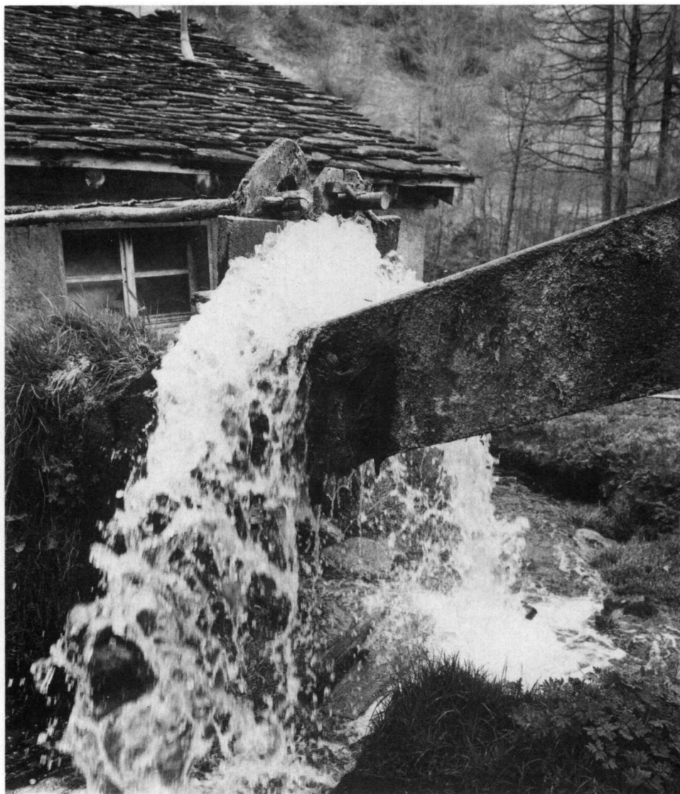
Pl. III. — Le moulin est arrêté. L'eau jaillit par-dessus la vanne fermée et retombe dans le canal de dérivation qui contourne le moulin. Photo Jean-Marc Biner, 1989.
