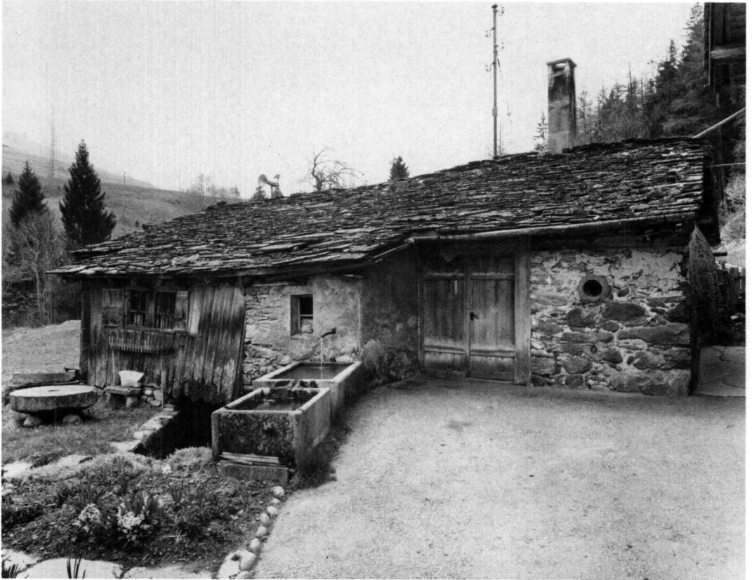
Pl. X. — Les moulins d'amont, façade nord et le canal de fuite. Photo Fibbi, 1984.
