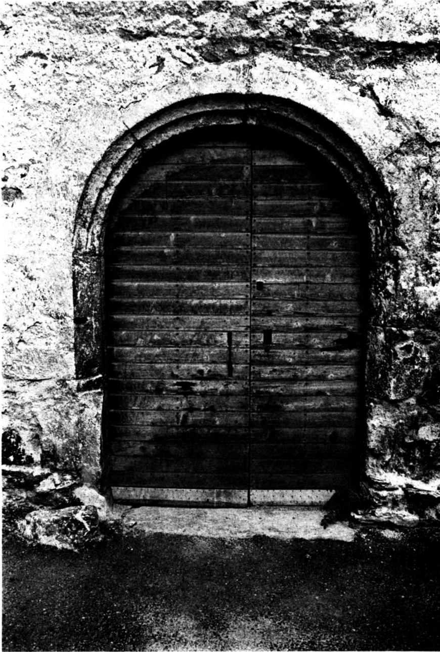
Taf. 13. — Scheune Nr. 99. Rundbogenportal in Tuff mit Doppelkehlenprofil.
