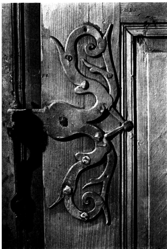
Taf. 5 b. — Schmiedeiserner Türbeschlag im 1609 erbauten Haus des Anton Albertini (Nr. 107). Gravierung durch Übermalung verdeckt.
