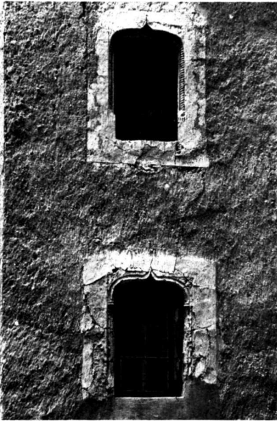
Taf. 11 a. — De-Werra-Landsitz in der Galdinen (Nr. 114). Kiel- bogenfenster mit Stuckgewänden am Südturm von 1532
