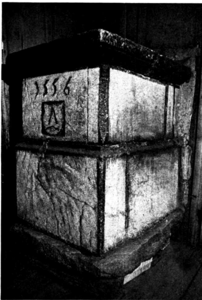
Taf. 10 b. — Haus Nr. 63 am Platz in den Tschablen. Eckiger Giltsteinofen von 1556.
