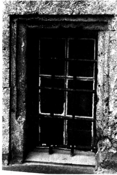
Taf. 11 b. — Haus des Michael Jenini (Nr. 11). Fenster am Trep- penturm mit profiliertem Tuff- steingewände. Um 1592.
