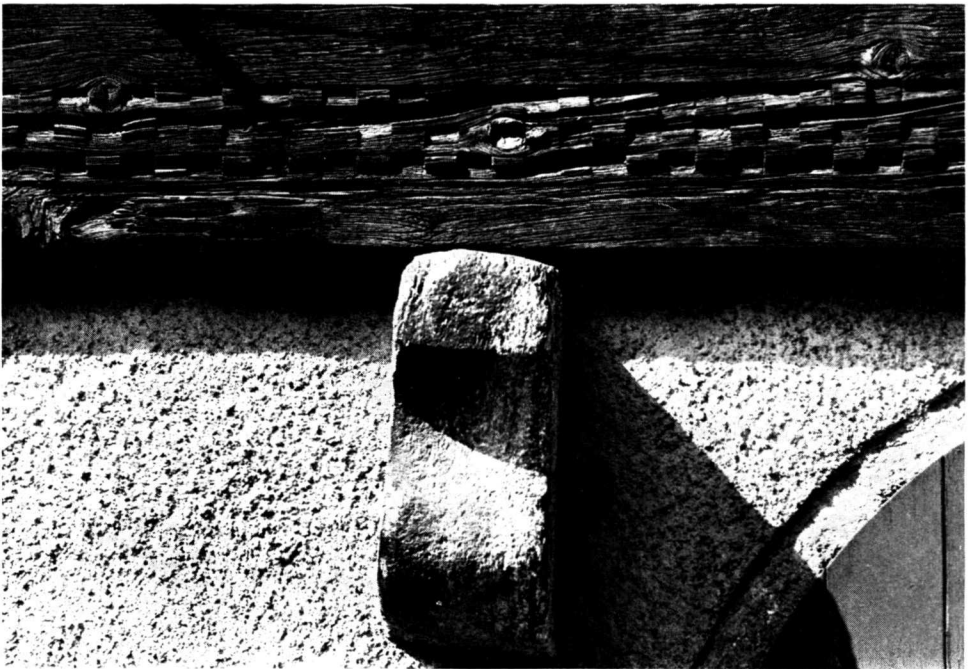
Taf. 6 b. — Grandhaus an der Kreuzgasse (Nr. 39). Kragstein im Mauersockel und unterster Balken des Blockbaus von 1672 mit Schachbrettfries.
