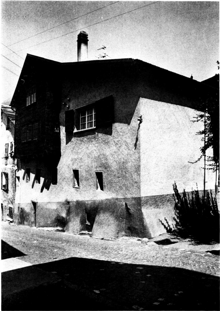
Taf. 14. — Bayardhaus an der Varenegasse (Nr. 93). Blockbau von 1670 mit jüngerem, massiven Anbau im Vordergrund.
