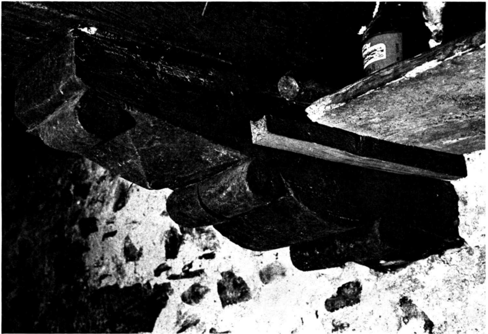
Taf. 6 a. — Älteres Gasnerhaus an der Schulhausstrasse (Nr. 79). Sattelholz im Erdgeschoss. Wohl aus der zweiten Hälfte des 15. Jahrhunderts.
