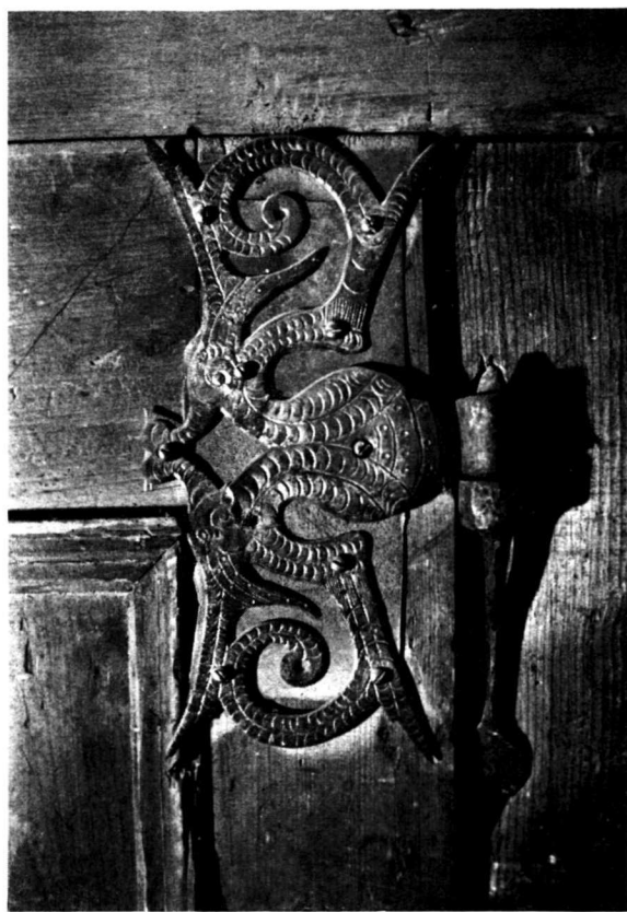
Taf. 5 c. — Schmiedeiserner Türbeschlag im 1611 weitgehend umgebauten Mageranhaus an der Kreuzgasse (Nr. 30). Gravierung mit Fabeltierköpfen.
