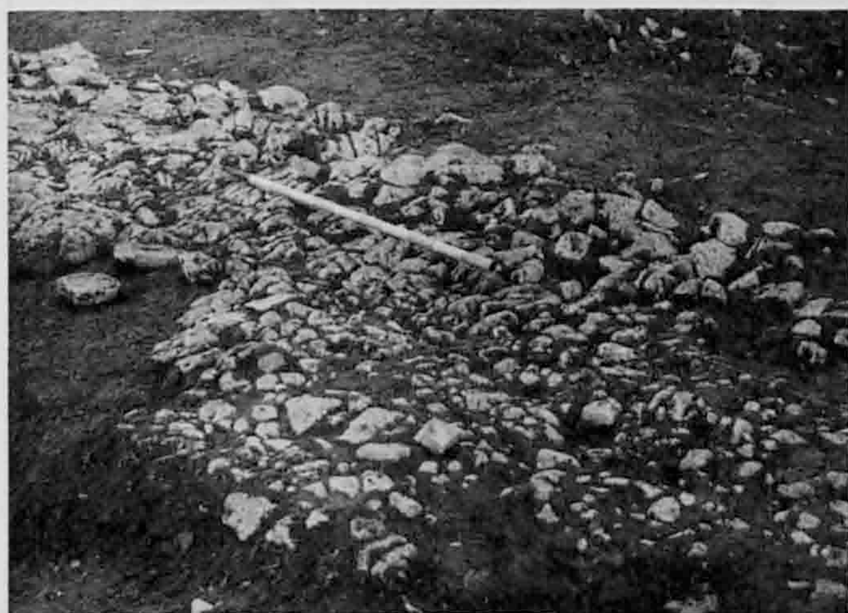
Fig. 39. Alle, Pré au Prince. Vue du bord est de la route. Le hérisson, encore intact en haut à gauche, est complètement disloqué à l'avant-plan.
