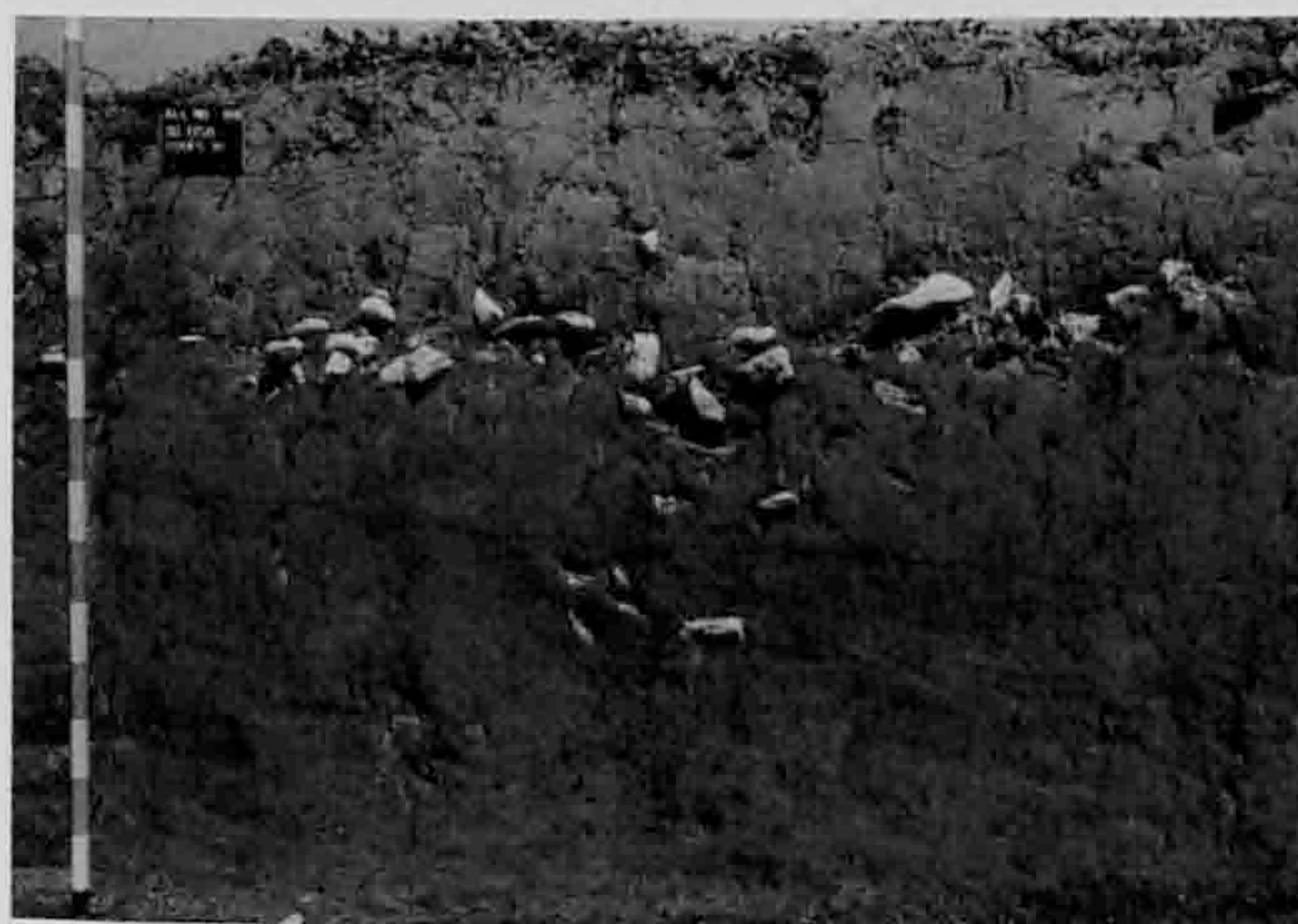
Fig. 20. Alle, Noir Bois. Vue vers l'est du fossé sud de la route (coupe 16), avec des cailloux calcaires piégés dans son remplissage.
