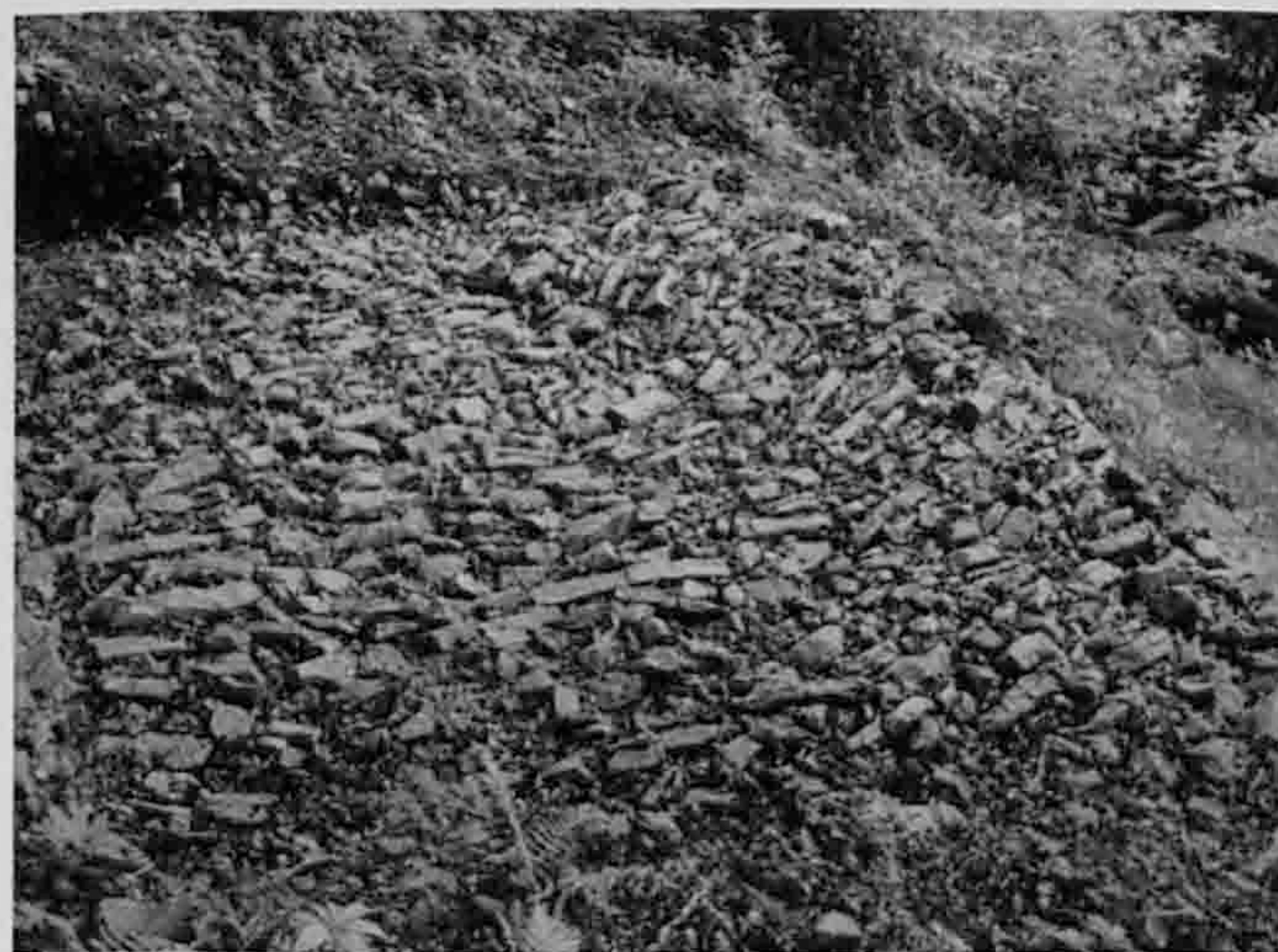
Fig. 89. Asuel, Les Rondins. Vue d'un tronçon de route empierrée.
