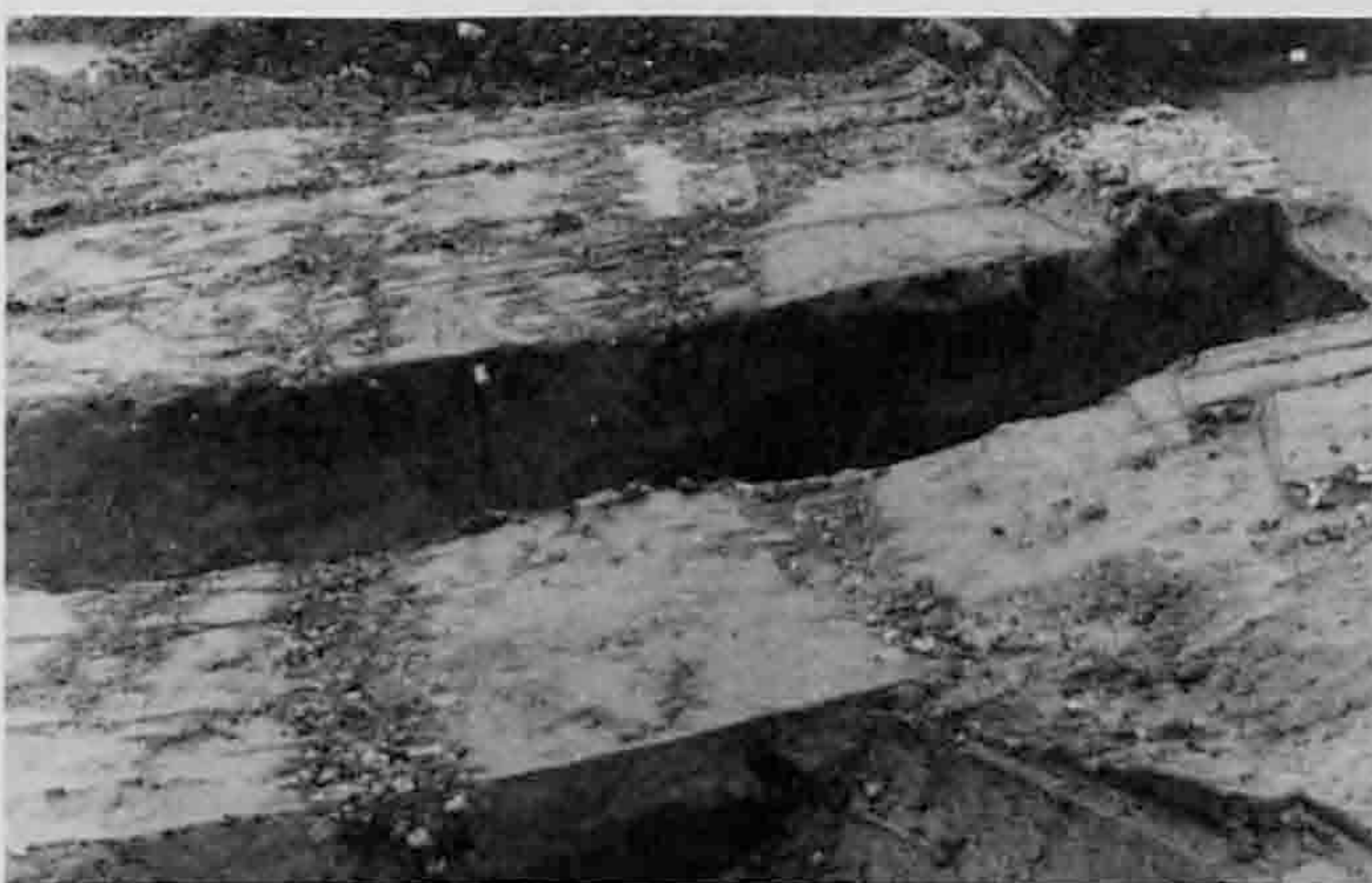
Fig. 33. Alle, Noir Bois. Vue de la route en direction de l'ouest, dans la partie orientale du site. Après enlèvement des blocs du hérisson subsistent des ornières profondément imprimées.
