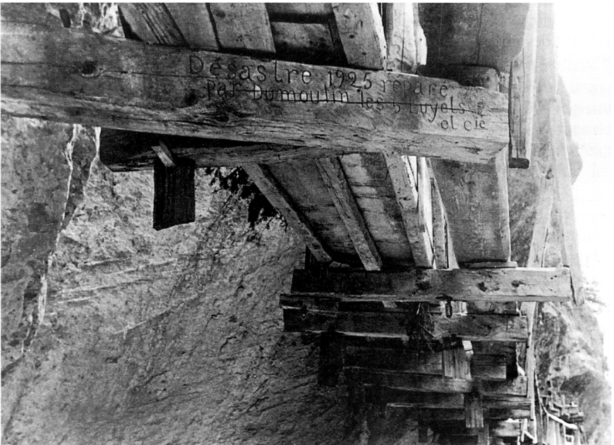
Bisse de Savièse, fixations dans le roc, vers 1930 (Raymond Schmid)
