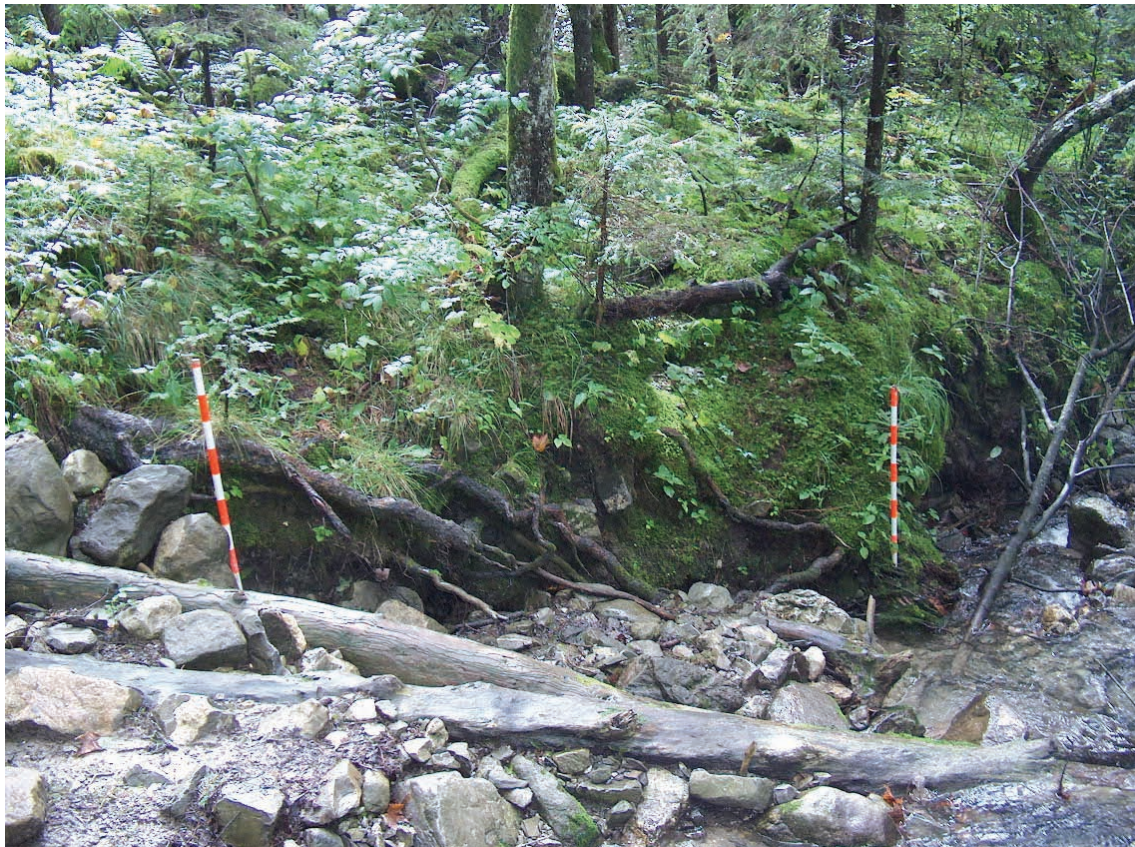
Abbildung 3: Ufererosion mit freigelegten Wurzeln im Steinibach.
