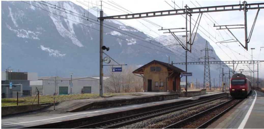
Abbildung 24: Sicht auf das Bahnhofgelände von Turtmann
