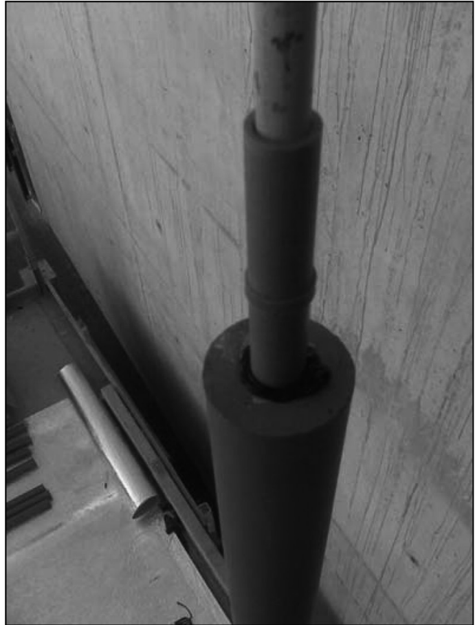
Figura 6. Fase de implementación del sistema en prototipo. Casquillo de polietileno empleado como separador. Cortesía de Butech.
