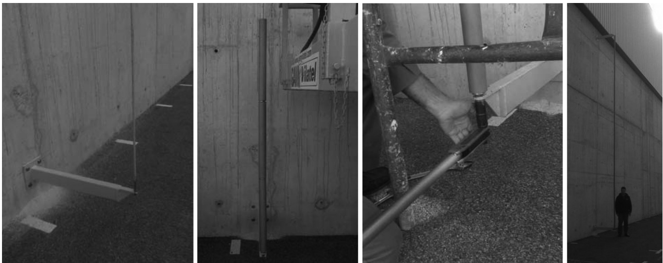
Figura 7. Fases sucesivas de prefabricación de la columnilla en taller. Barra de guía, inserción de pieza, pretensado por la parte inferior mediante llave dinamométrica y situación final. Cortesía de Butech.
