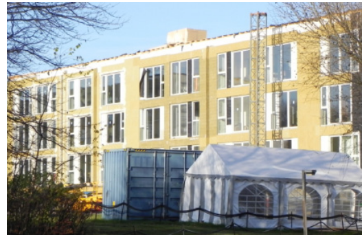
Foto 6: Efterisolering af facaden
