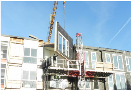
Foto 5: Montage af facademoduler
