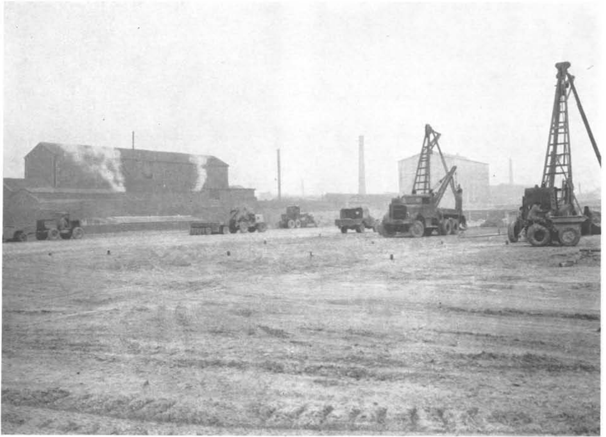
Perforadoras, compactadores y niveladoras consolidan y preparan el terreno.
