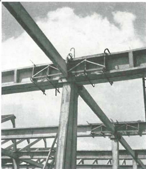
Diversas fases de montaje.
