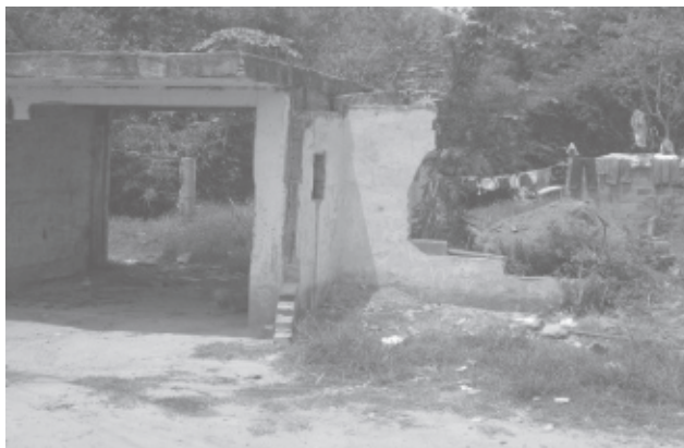
Figura 3: Vivienda del asentamiento Convivir, después de la inundación de 2005
