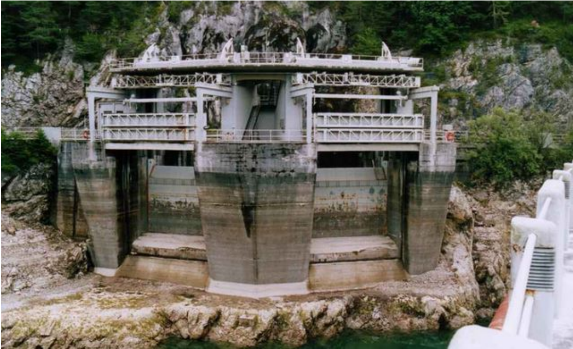
Figura 1.5: Scarico di Superficie diga Pieve di Cadore.
