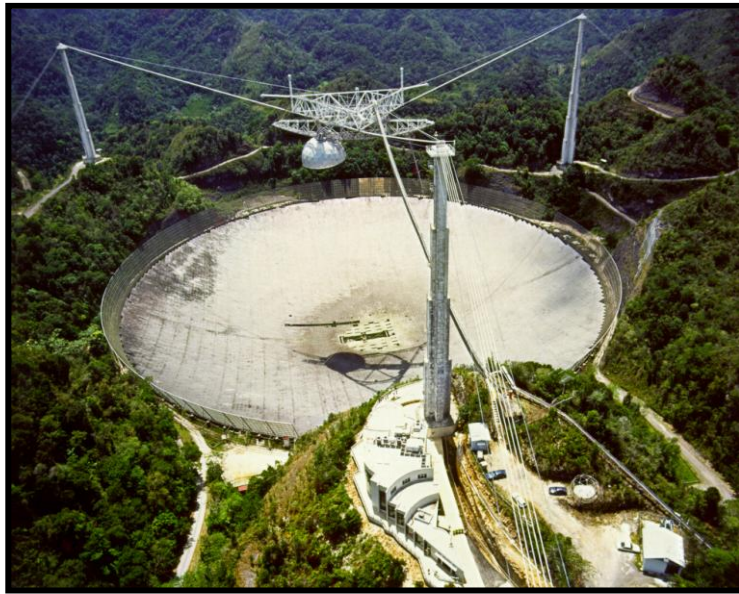
Figura 5.3 – Antena reflectora de Arecibo, Puerto Rico, utilizada como radiotelescopio ( video ).
