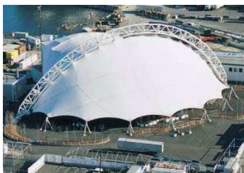
1. ábra: Egy rácsos ívre hagyományos módon, rövid, független kábelekkel feszített ponyvaszerkezet (Bank of America Pavilion, Boston, MA, USA)
