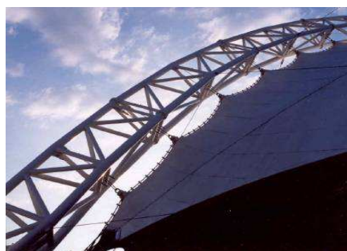
1. ábra: Egy rácsos ívre hagyományos módon, rövid, független kábelekkel feszített ponyvaszerkezet (Bank of America Pavilion, Boston, MA, USA)
