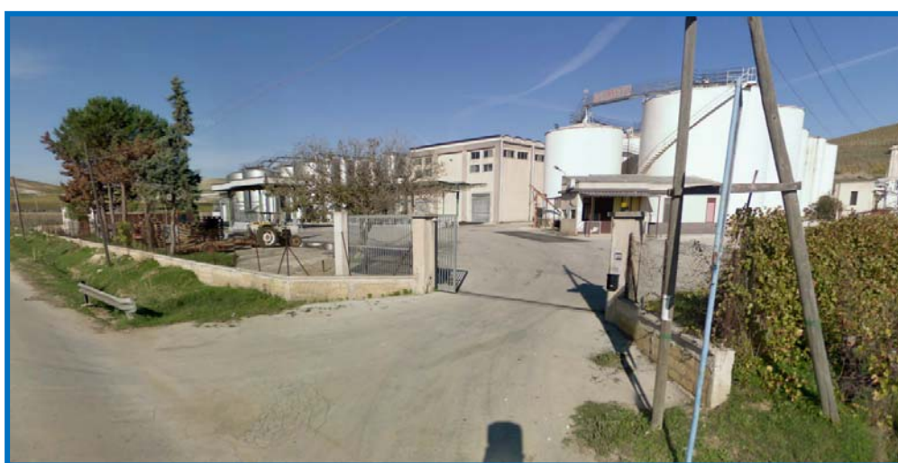
Figura 49: Stabilimento "Torretta" di Salemi (TP) 154
