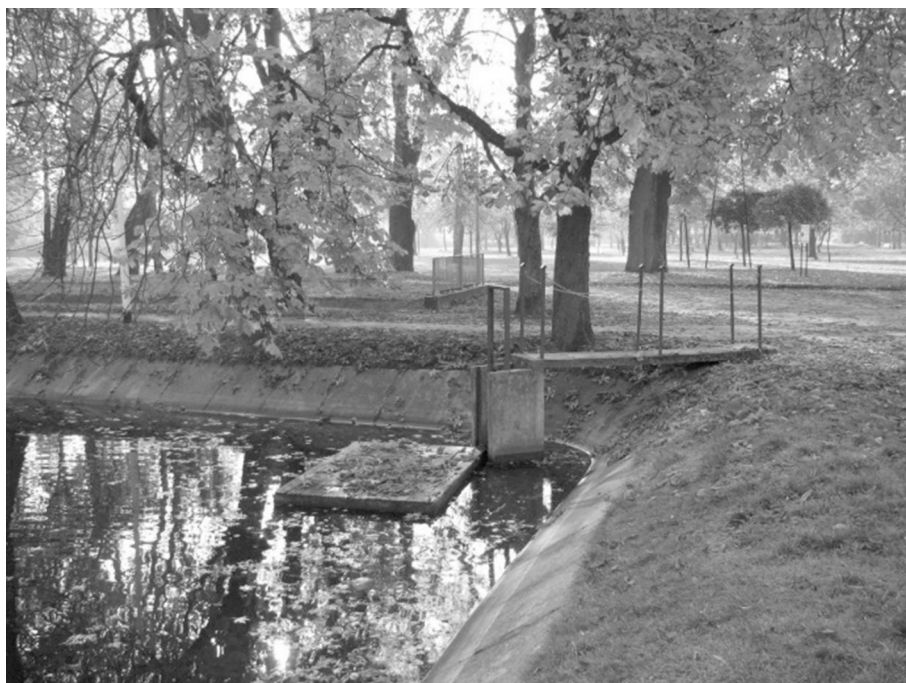
Ryc. 3. Urządzenia hydrotechniczne w mniejszym stawie. Widok od strony północnej (fot. M. Milecka)
