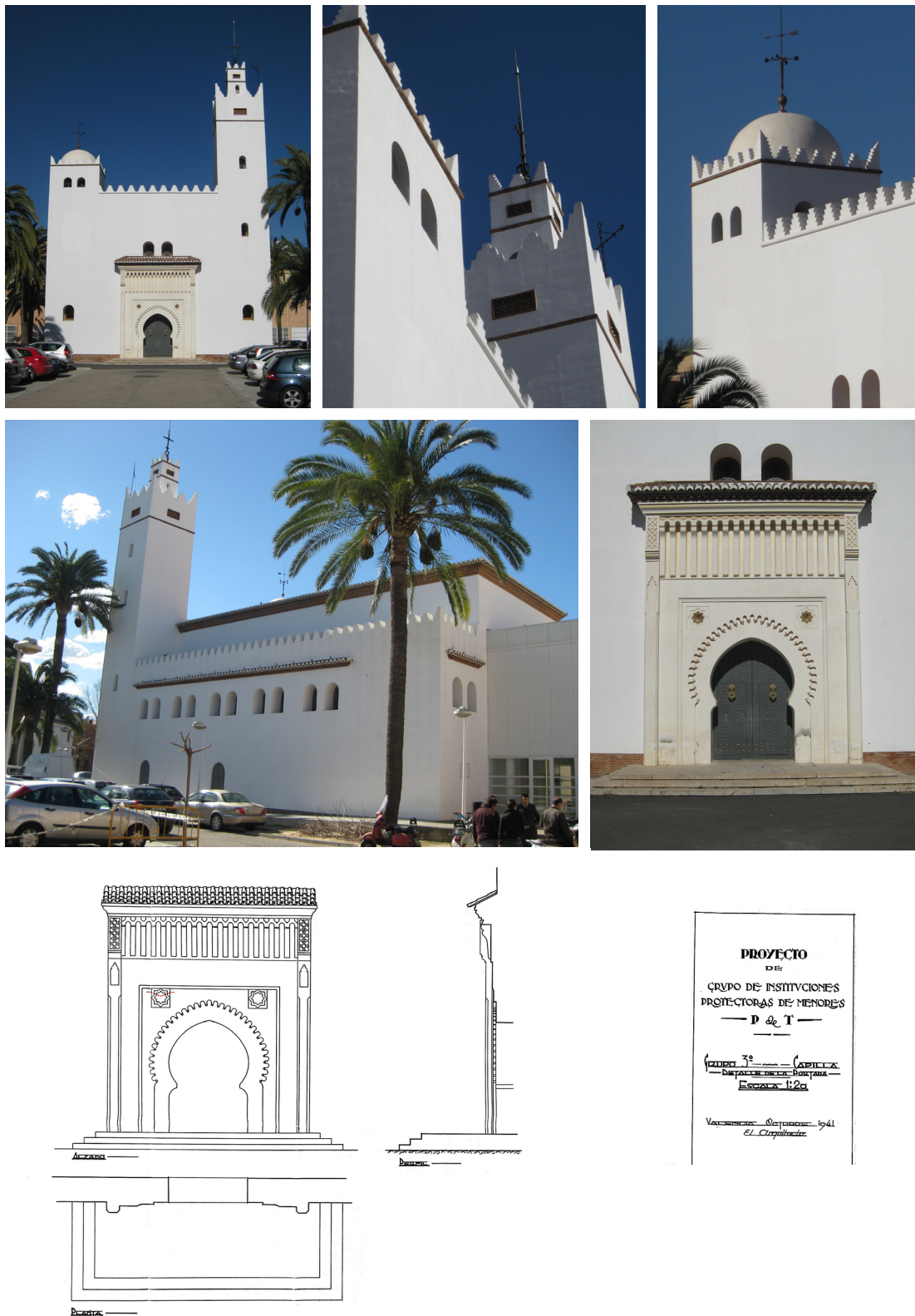
Figura 4 A. Estado actual de la fachada principal. 4 B. Torre de la derecha o alminar, con su azri. 4 C. Torre de la izquierda, cubierta con cúpula semiesférica. 4 D. Estado actual de las fachadas laterales. 4 E. Puerta de acceso, de estilo tetuaní. 4 F. Plano de planta, alzado y sección de la puerta de acceso, E:1/20, octubre de 1941.
