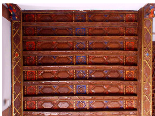
Figura 10 A. Alfarje que cubre las naves laterales (tras la restauración), en la imagen se observan las ventanas resueltas con arco de medio punto y pareadas que iluminan y ventilan estos espacios. 10 B. Alfarje que cubre el sotacoro (antes de la restauración).
