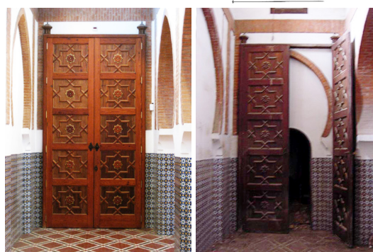
Figura 8 A. Plano de carpintería interior, E:1/20, octubre de 1941. 8 B. Una de las ocho puertas interiores, con el mismo diseño magrebí que la puerta de acceso, hoja exterior. 8 C. Puerta anterior, hoja interior, solapando sobre el hueco y no ajustando en el mismo.
