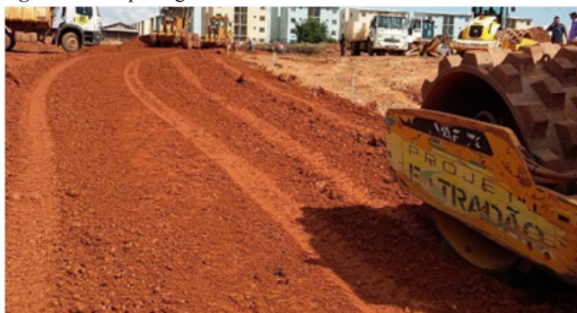
Figura 5. Terraplanagem do terreno.
