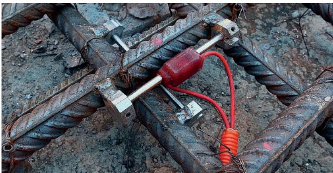
Рис. 10. Тензометры, смонтированные на арматуре нижней плиты КФ
