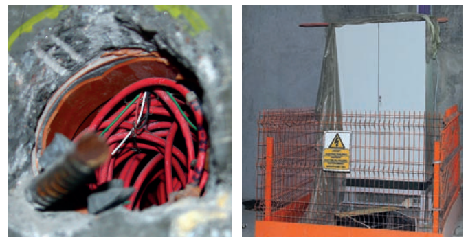
Рис. 12. Закладная деталь с кабелями тензометров, вскрытая после демонтажа опалубки стены КФ Рис. 13. Размещение щитов сбора данных в коробчатом фундаменте
