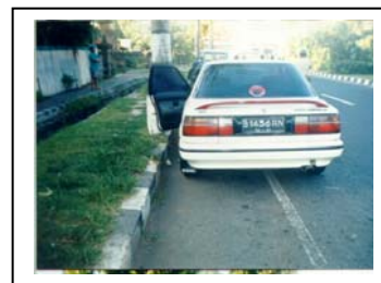
Gb 2: Tinggi kerbs 20 cm lebih dipinggiran jalan di Denpasar
