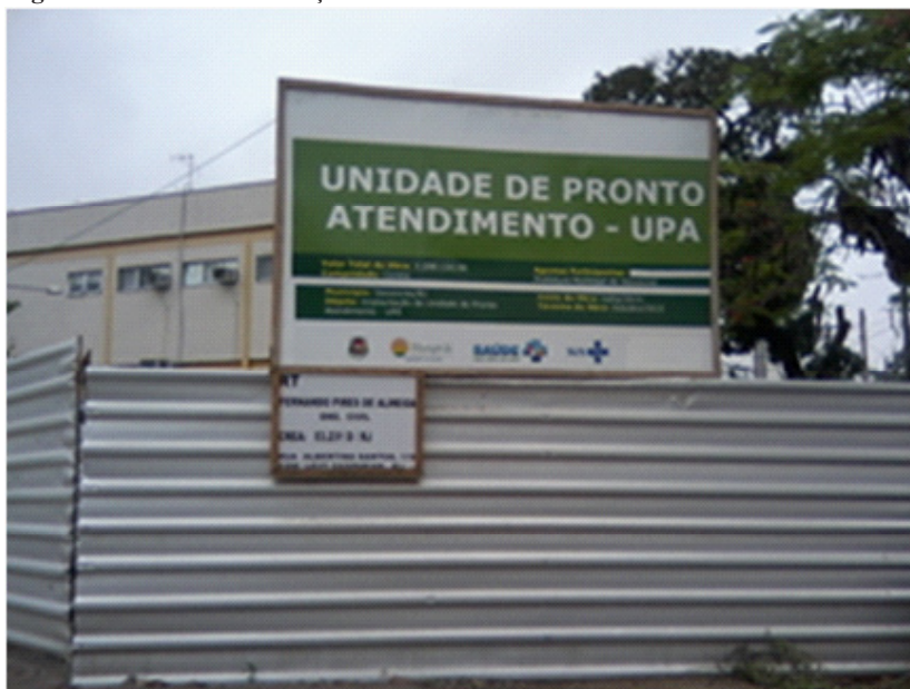
Figura 1. Placa de identificação da obra da UPA Vassouras/RJ.
