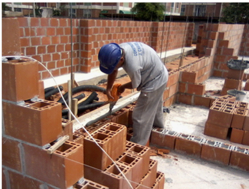
Figura 4. Execução da obra com alvenaria estrutural: Utilização da bisnaga para aplicação da argamassa para assentamento dos blocos estruturais cerâmicos.
