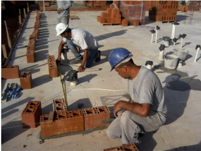
Figura 2. Execução da obra com alvenaria estrutural: Marcação da primeira fiada.
