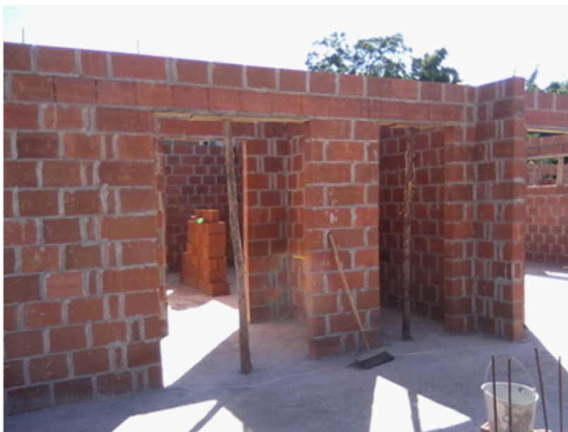
Figura 5. Execução da obra com alvenaria estrutural: Assentamento dos blocos estruturais cerâmicos e confecção da verga para reforço estrutural com bloco canaleta U.
