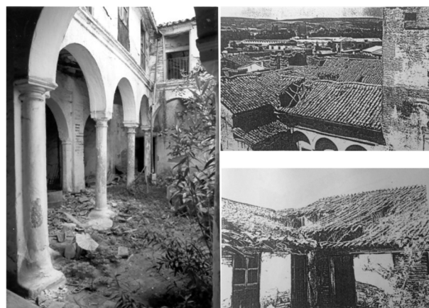
Figura 5: Patio interior y cubiertas antes de la intervención en 1989. Fuente: "Andújar en el arte y la historia" y "Proyecto de Rehabilitación de la Casa-Palacio".
