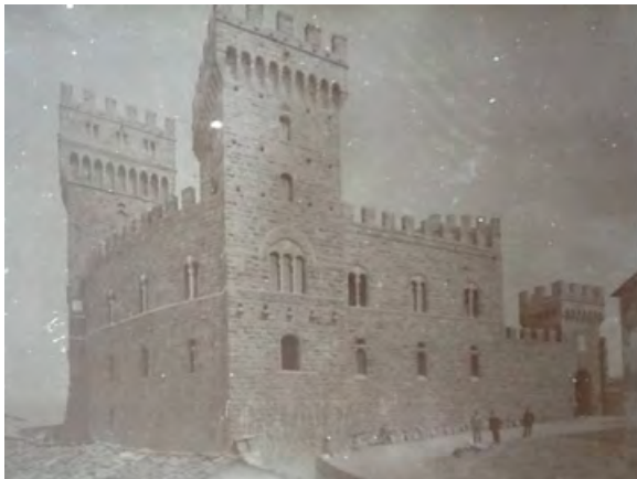
Figura 11. Torre Alfina, l'ala e la torre aggiunte da Partini nel lato d'ingresso del castello in una fotografia dei fratelli Alinari scattata alla fine dei lavori (da Fratelli Alinari 1892).
